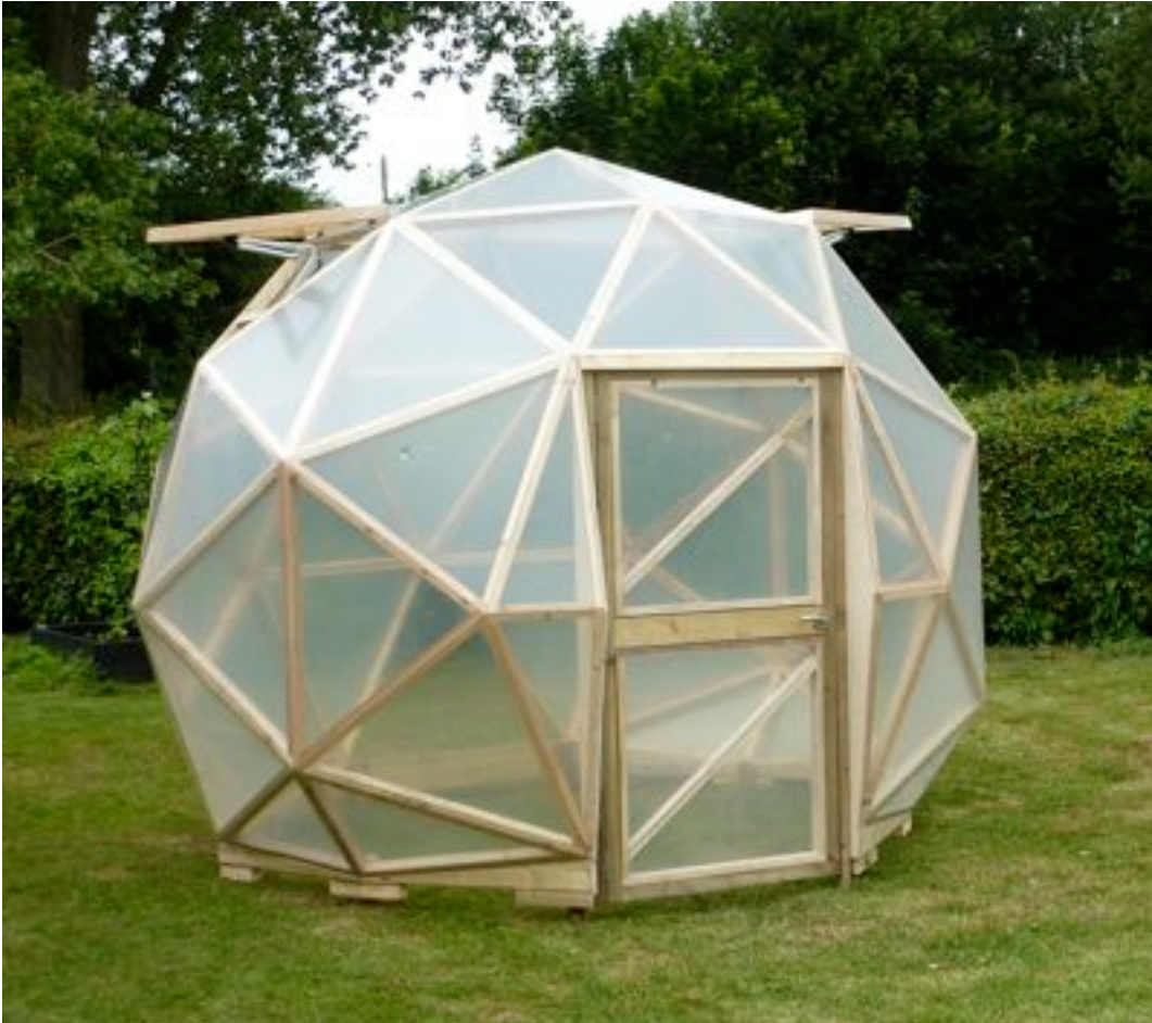
Prototyp eines noch unverkleideten Kugelhauses. Das gesamte Kugelhaus wird mit Rettungsdecken (Goldfolie) ummantelt.
